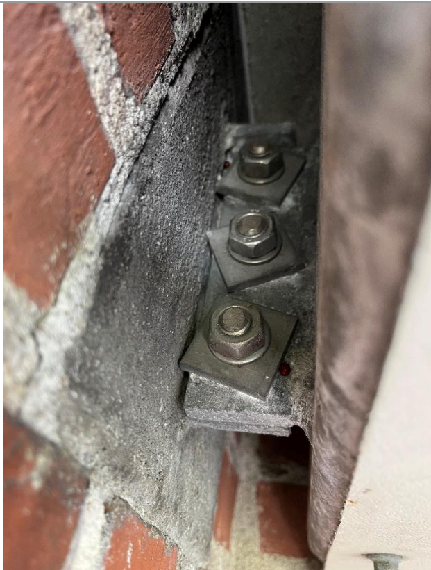
Foto 16: Stålele fremstår generelt i pæn stand helt uden spor af korrosion eller rust. Cementmørtlen, som beslaget er indstøbt i, fremstår ligeledes uden revner eller øvrige tegn på nedbrydning.
