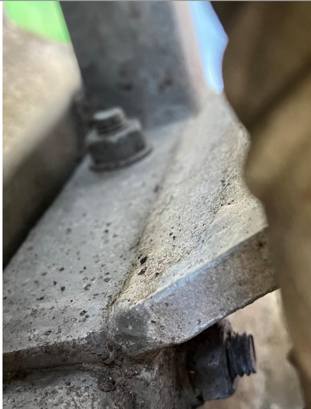
Foto 12: Bærebeslag og boltesamlinger til rækværk fremstår generelt intakt (disse er besigtiget på altan beliggende 4. TV.).
