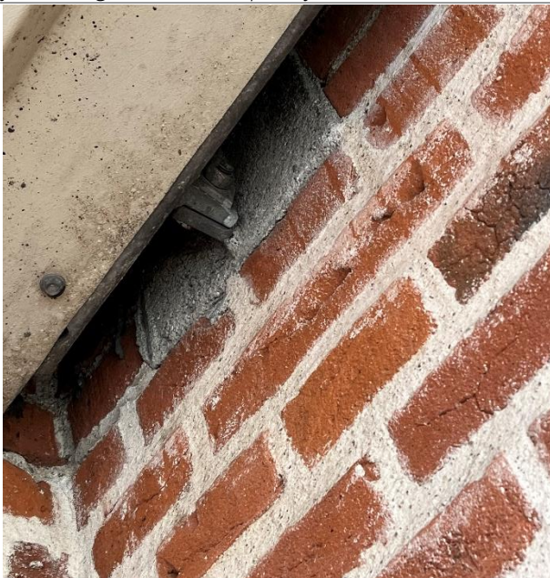
Foto 13: Bærebeslag og cementmørtel fremstår uden synlige tegn på korrosion/nedbrydning. Beslagene er synlige fra undersiden på den væg, som er orienteret vinkelret på facade med altandør.
