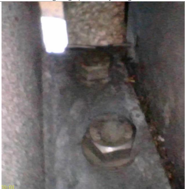
Foto 18: Foto taget med endoskop af beslag, i område, hvor bærebeklagene ikke er synlige. Ingen tegn på nedbrydning observeret på stådelene.
