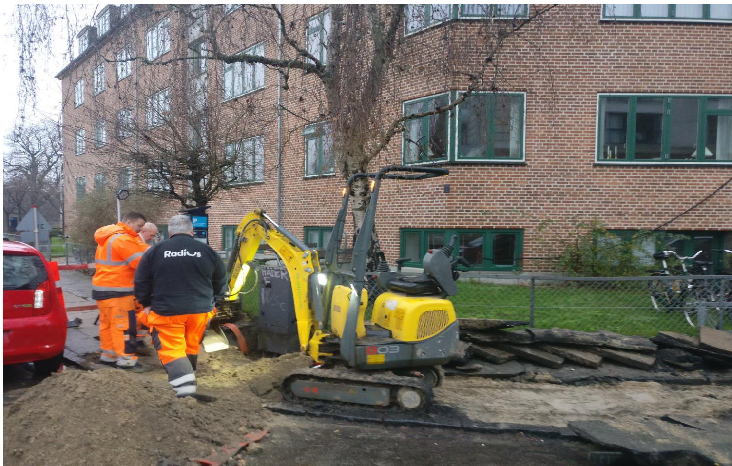
Gravearbejde 10. januar 2020 ifm. udskiftning af ejendommens hovedstrømsforsyning
