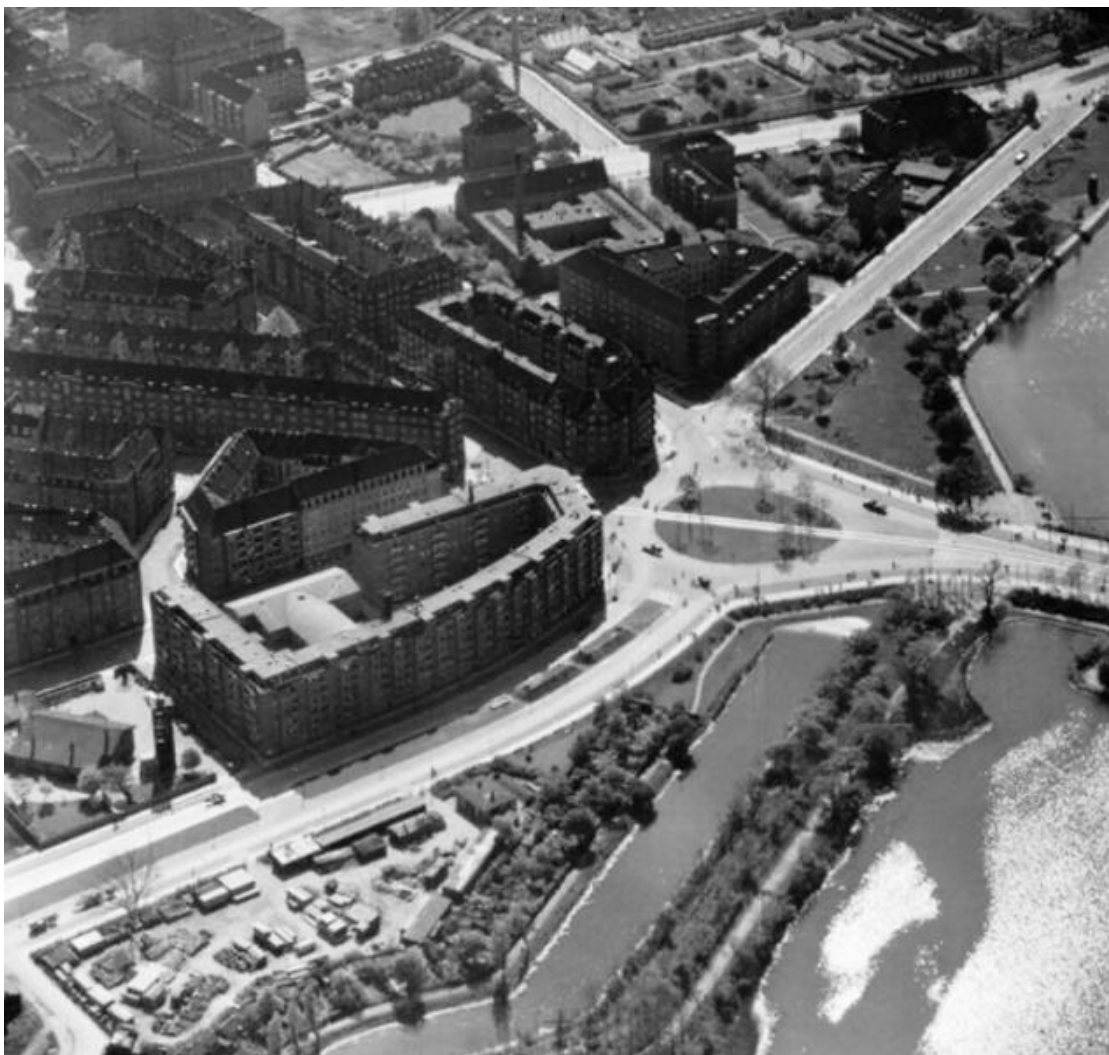
Luftfoto 1945 – Brandstationen på adressen Amagerfælledvej 2 er nedrevet og flyttet til Markmandsgade 15. Bemærk, ingen bunkere langs Ved Stadgraven.
